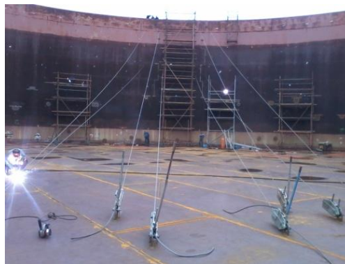
Slika 4 – Ispravljanje deformacija omotača
