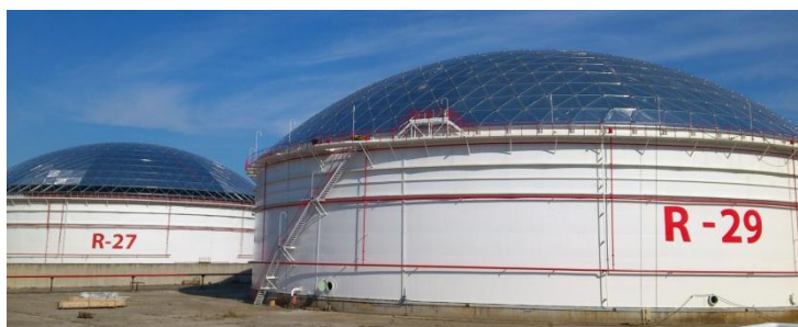
Slika 1 - Rezervoari nakon sanacije
