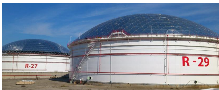
Slika 1 - Rezervoari nakon sanacije
