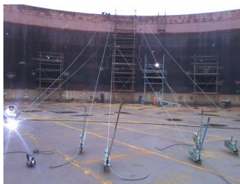
Slika 4 – Ispravljanje deformacija omotača
