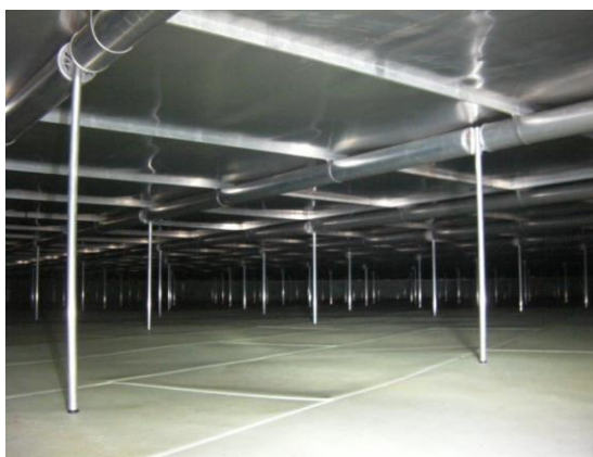
Slika 9 – Membrana u svom radnom položaju
