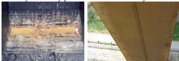
Slika 5: Oštećenja stubova
