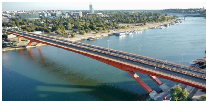
Slika 16 :Most Gazela nakon sanacije
