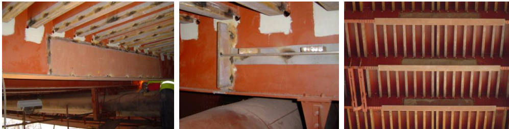
Slika 11: Ojačanja između sanduka mosta
