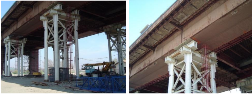
Slike 13: Montaža ojačanja donjeg pojasa sanduka mosta
