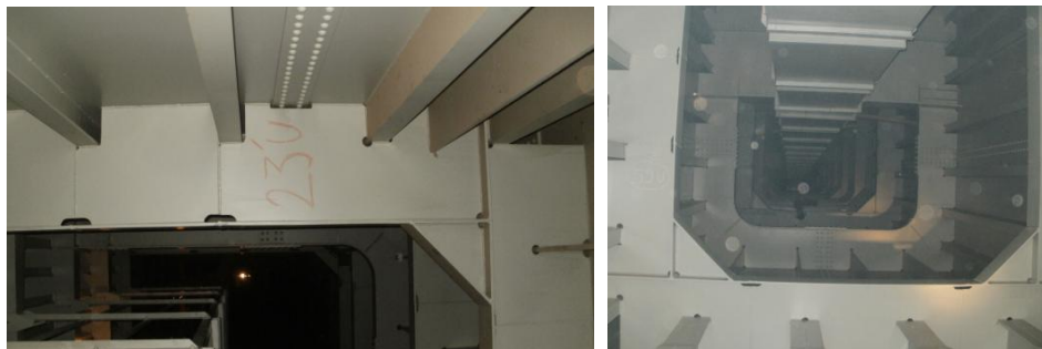
Slika 10: Ojačanja unutar sanduka mosta
