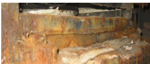
Slika 8: Oštećenja ležišta
