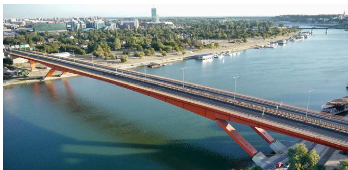
Slika 16 :Most Gazela nakon sanacije
