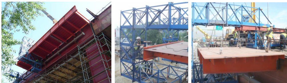
Slika 12: Montaža konstrukcije novih pešačkih staza
