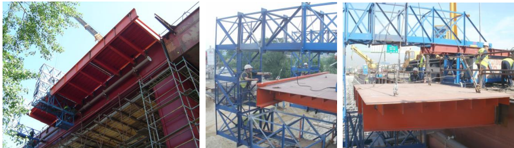
Slika 12: Montaža konstrukcije novih pešačkih staza
