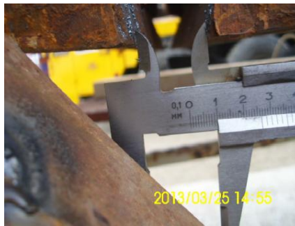
Slika 3 – Izmereni otvor žleba na jednom od montažnih spojeva.
